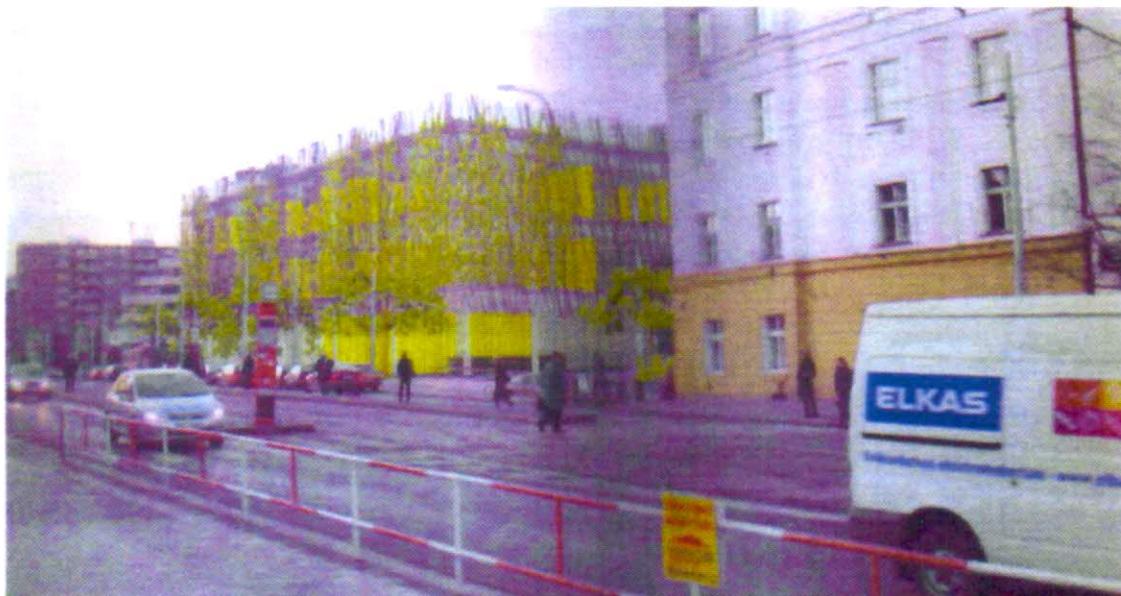
Obr. umístění objektu MOS v bezprostřední blízkosti komunikace
